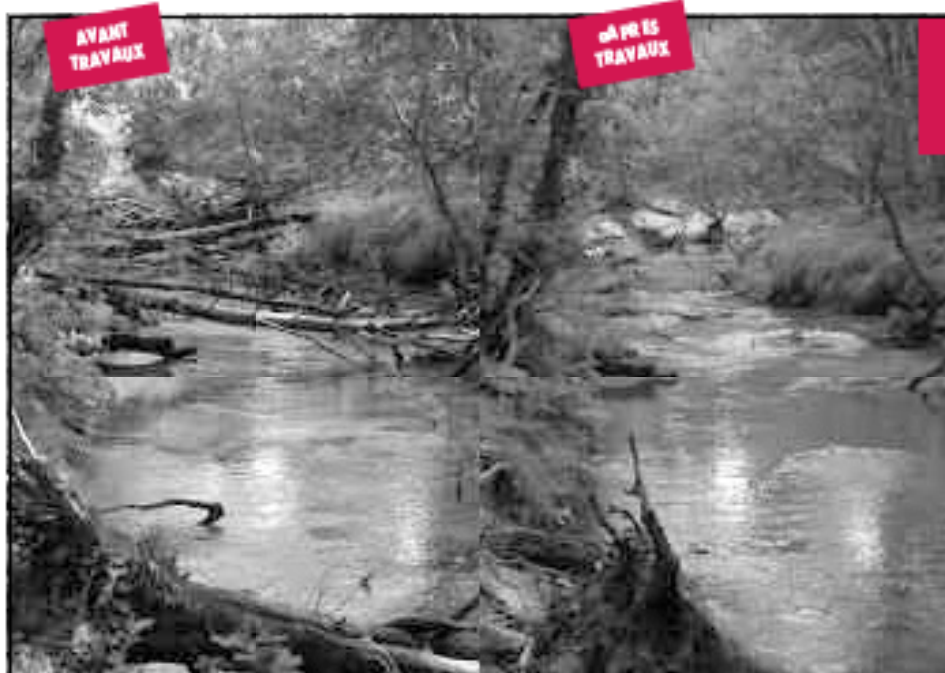
Tronçons petite Leyre avant et après travaux, étiage 2004.
