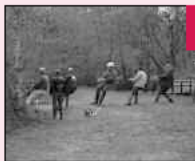
Travaux en bord de Leyre en chantier école
